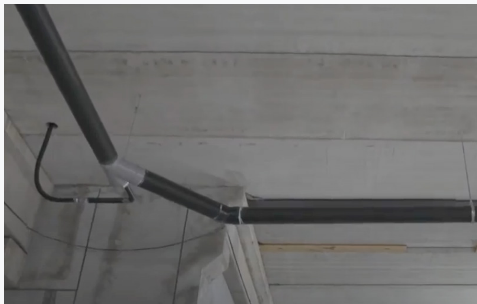
Figura 14: Tubulações no sistema Quickstream Fonte: Material Institucional Amanco
