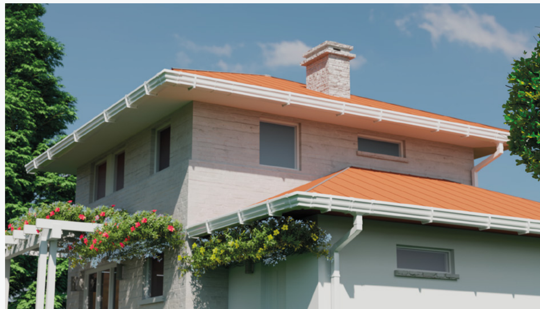
Figura 10: residência com calha moldura Fonte: Própria
